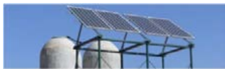
Figure 32: Système solaire photovoltaïque pour l'arrosage (Source: Eraingenieria)
