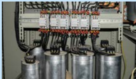
Figure 7: Mise en place de batterie de condensateurs
