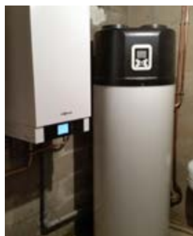
Figure 17: Chaudière à propane
