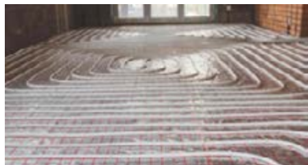
Figure 33: Installation de chauffage solaire par sol radiant (Source : Tecnisolar)
