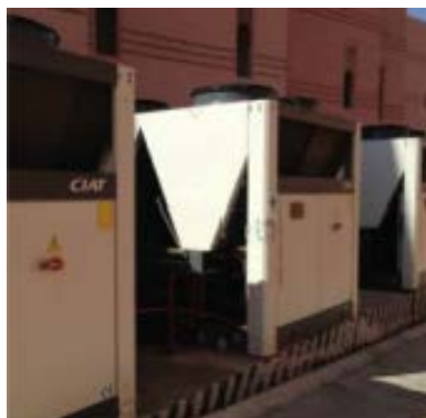
Figure 3: Installation de climatisation centralisée par Pompe à Chaleur
