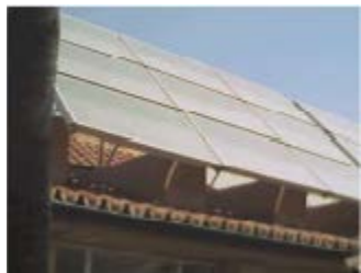
Figure 34: Installation solaire pour la climatisation de piscine couverte d'un hôtel (Source : élaboration propre)
