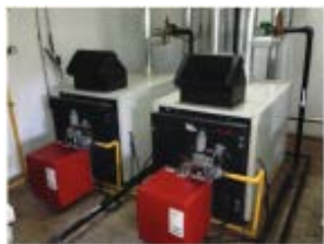
Figure 20: Chaudières à basse température
